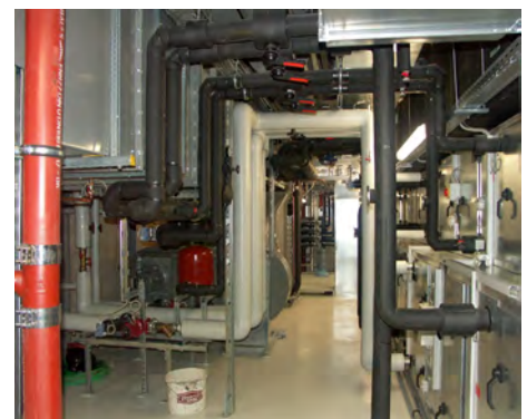
Foyer Budapester Straße
