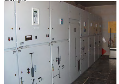
MS-Schaltanlage
