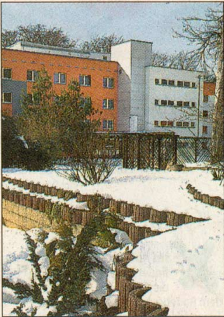
Das 1981 eingeweihte Schulgebäude wurde 2003/04 umfassend saniert.
